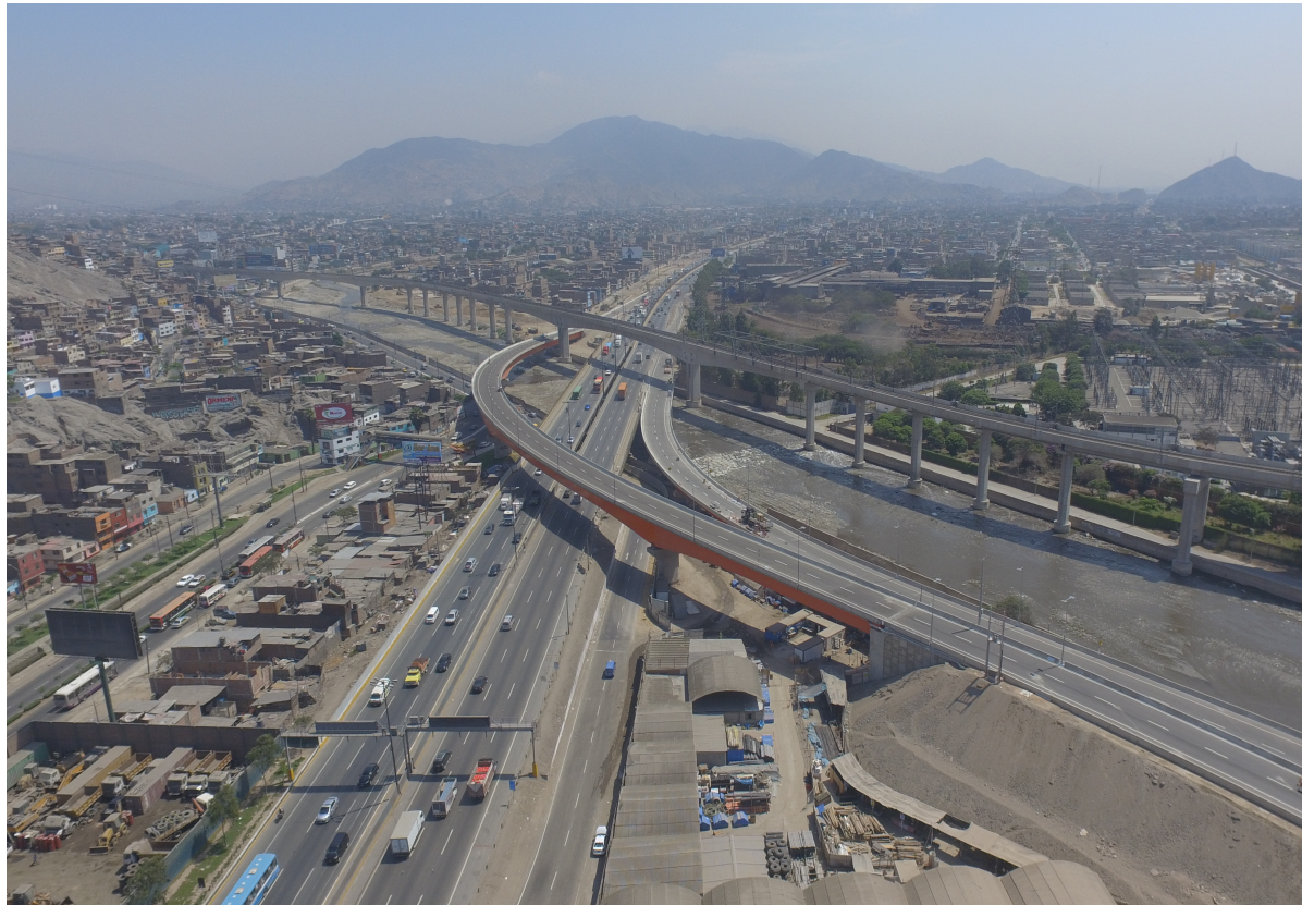
Ouverture à la circulation de la section 2 de la voie express de Lima, en juin 2018 (Pérou)
