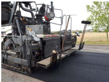
La technologie Eurovia de route 100% recyclée
