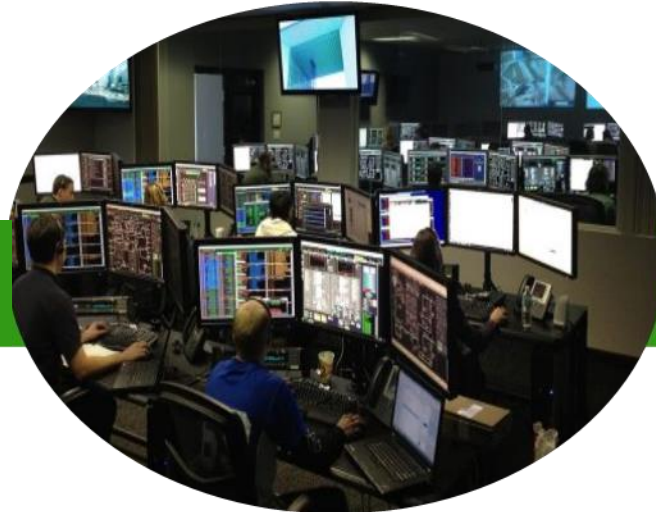
VINCI Energies Hypervisor platform at La Défense
